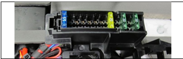
Detail A: Sicherungshalter - Abnahmepunkt für Zweitatterie
